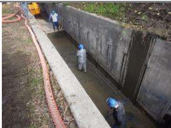
<バキュームカーで吸引した泥水の処理作業の様子>
