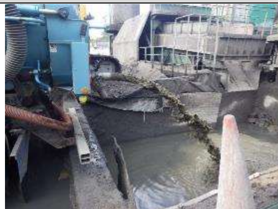
<高圧水による水路洗浄の様子>
