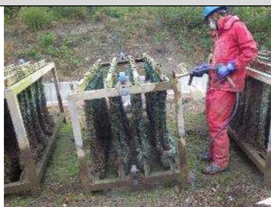
<モールコードの交換作業の様子>
