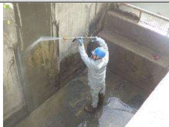
<高圧水による水路洗浄の様子>
